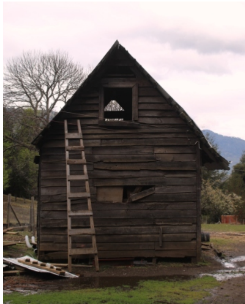
Foto 7 Casa antigua de colono, se aprecia la disposición de tablas tingladas de madera labrada.
