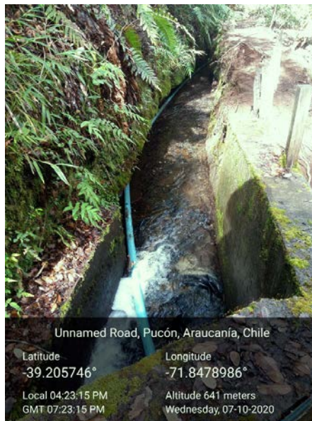
Foto 6 Desvío de agua y canalización, sector Carhuello.
